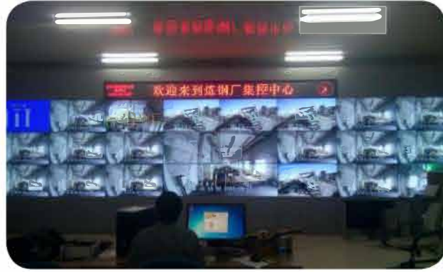
▲ 辽宁营口五矿钢铁厂项目
